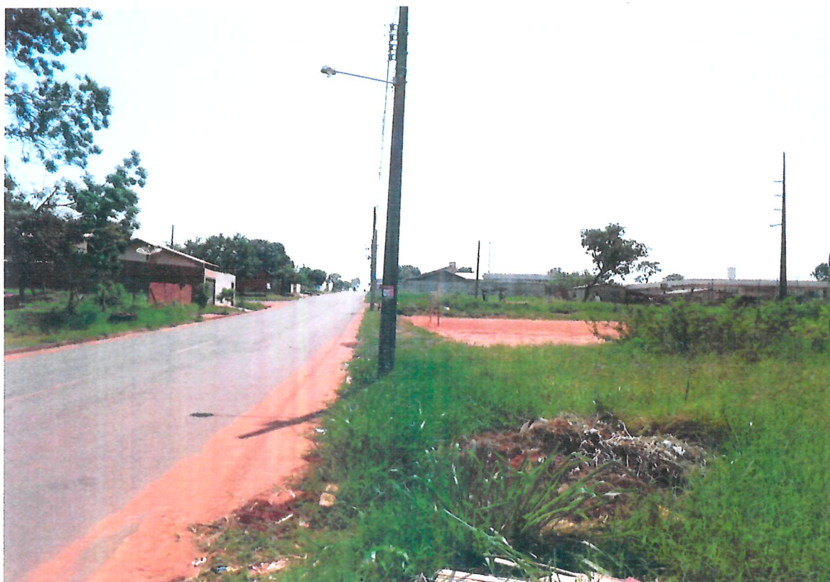
Rua Nefe Pael com asfalto, rede de energia, rede de água e iluminação pública.
