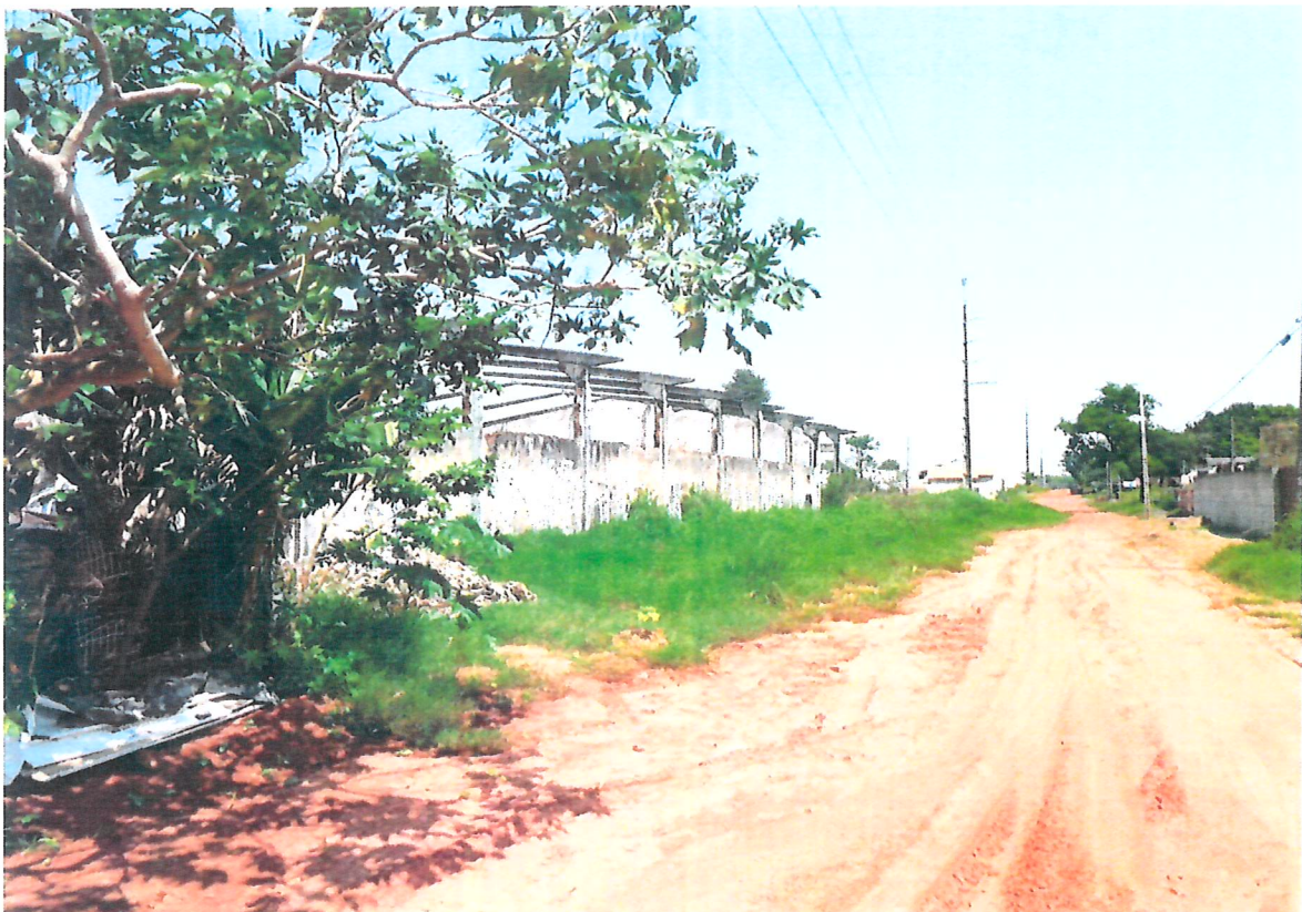
Rua Hipócrates sem asfalto e linha de transmissão de alta tensão.
