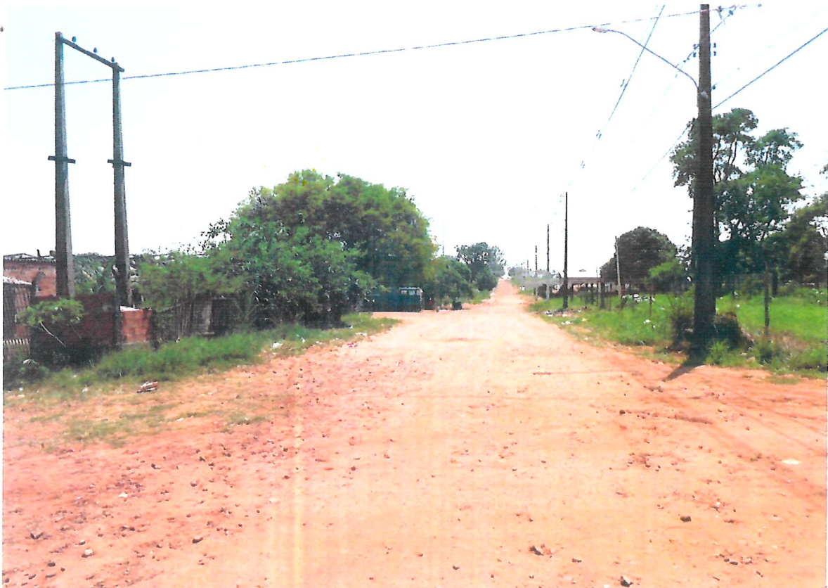
Rua Celina Baís Martins sem asfalto, possui rede de energia e água.
